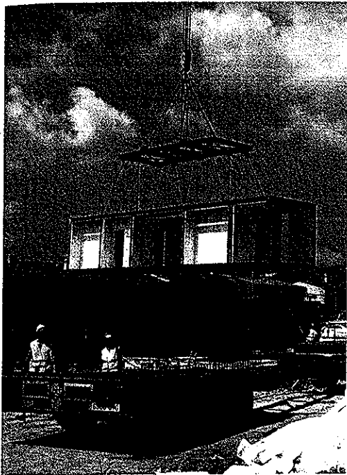
La operación de izado y acoplamiento de los módulos necesitó de una grua móvil modelo Terex Demag 39
