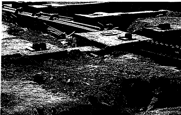
Los módulos se han encajado en los cimientos ya preparados sobre el terreno
