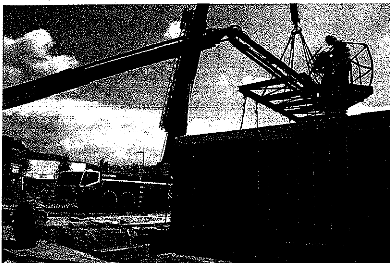
Una vez acoplado el módulo a la base había que dejar lista la parte superior
