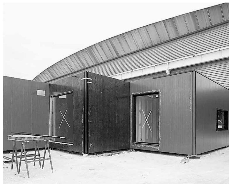
Parte de los módulos de la terminal. ■ E. C.
