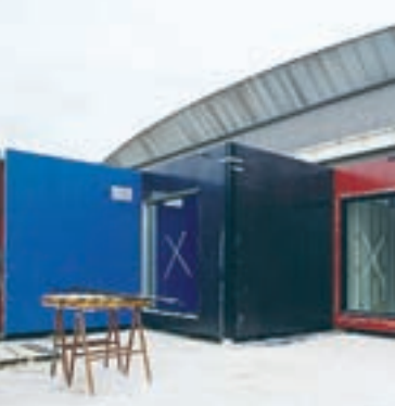
Imagen de las obras del Musel.
