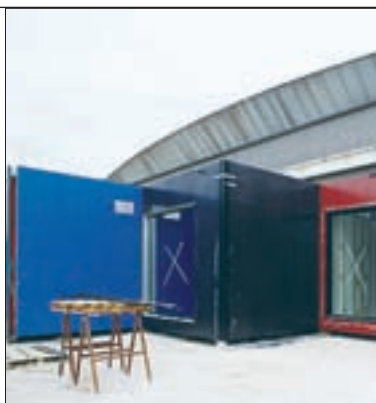
Imagen de las obras del Musel.
