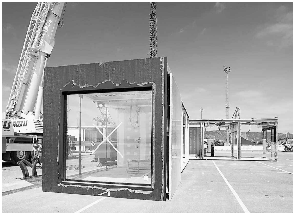
Colocación de los primeros módulos de la nueva terminal en los muelles de La Osa. :: E. C.
