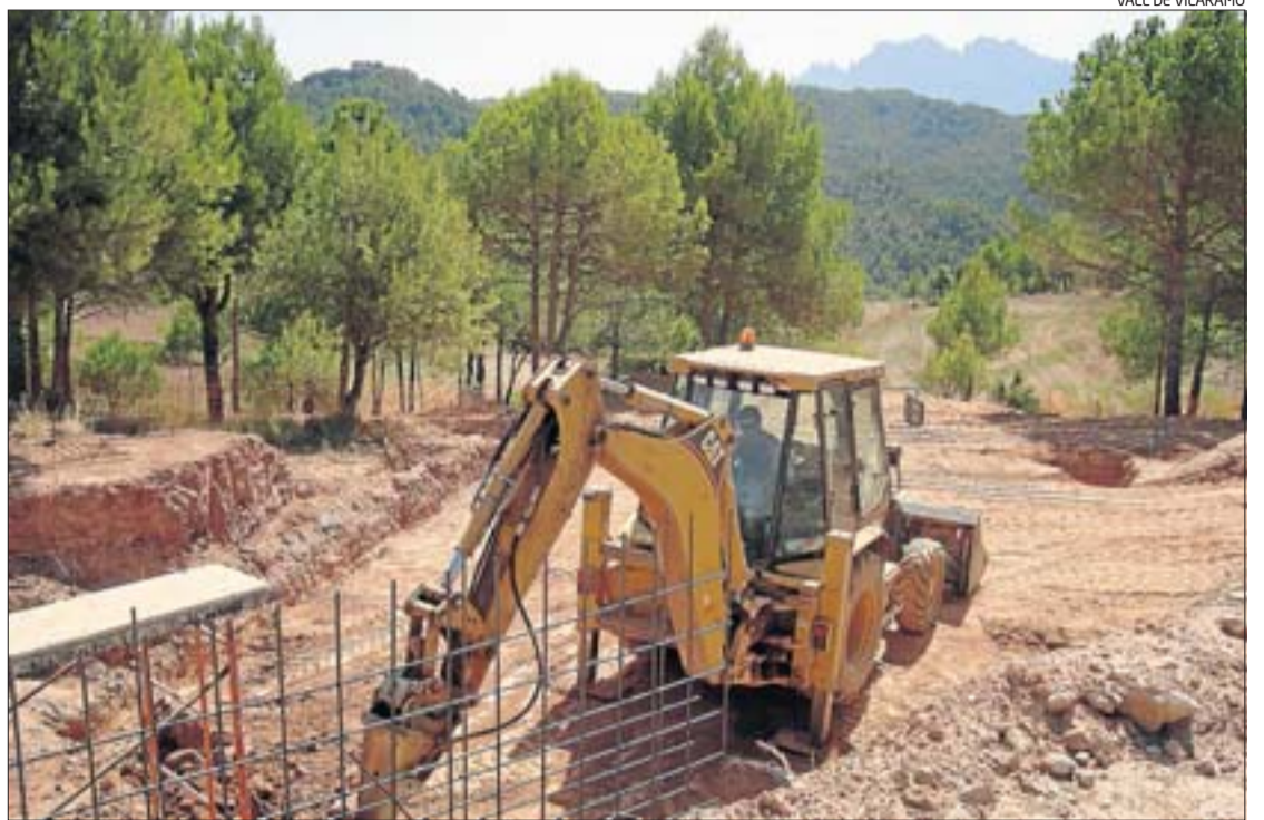
Les obres de construcció del nou equipament de la finca Urpina, amb vistes a Montserrat, ja estan en marxa
