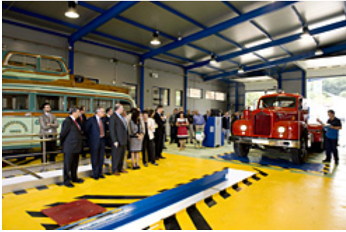
Interior de la nueva estación de ITV en Santesteban, inaugura hoy por el Presidente Sanz.
