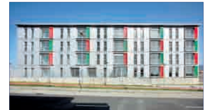
▲ Edificio de viviendas en Torelló (Barcelona) / 2.511 m2 / 6 meses.
