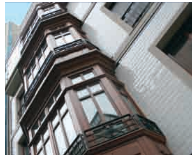
▲ Edificio en Gijón (Asturias) / 510 m2 / 4 meses.
